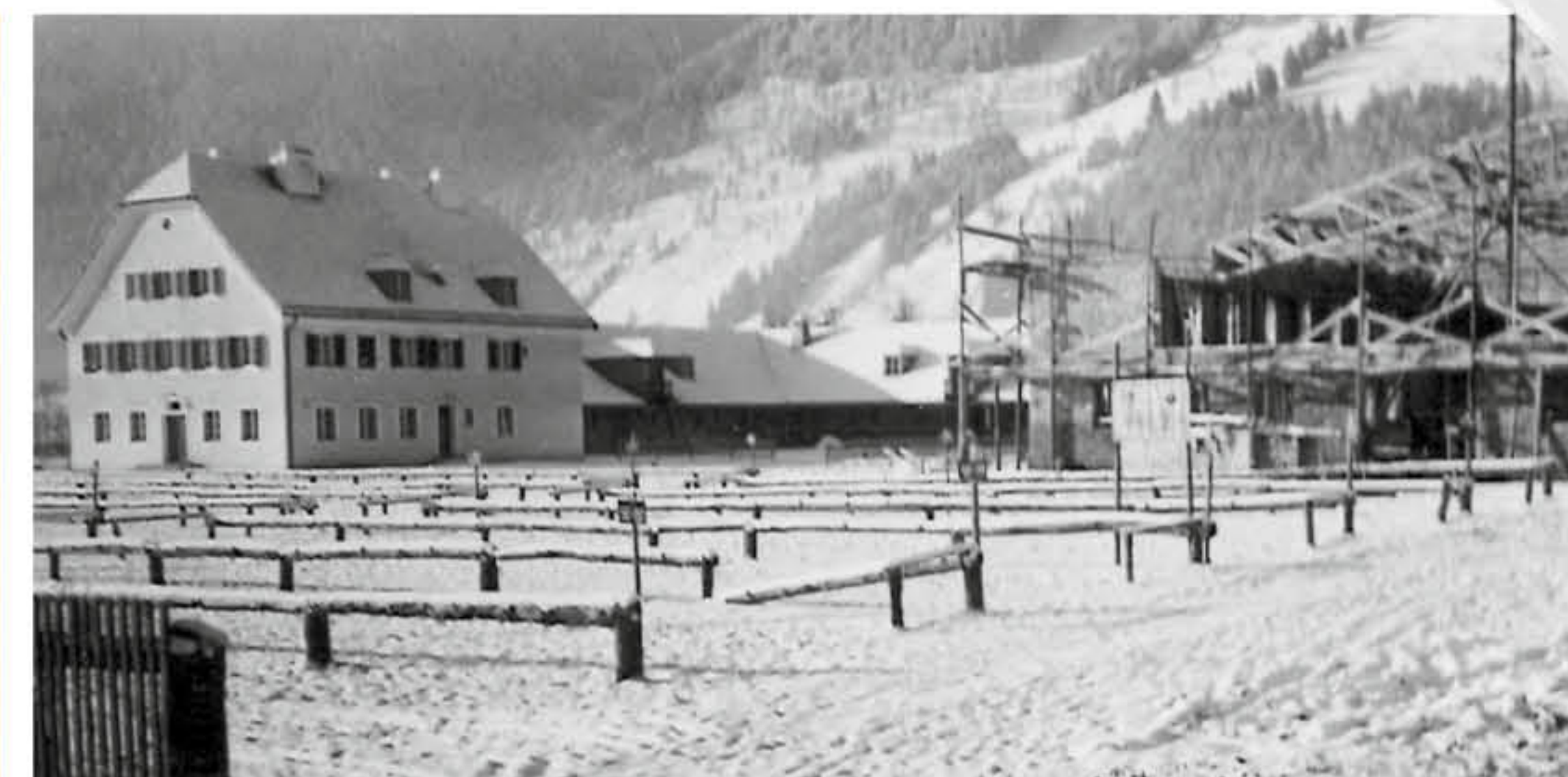
Bau der Verbandsanlage Winter 1950/51
