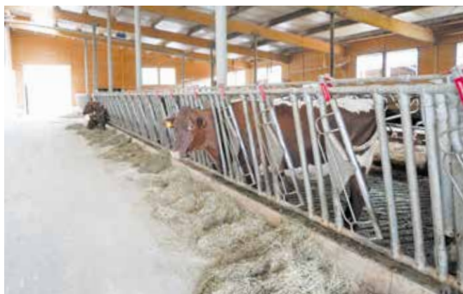
Angrenzend an den Altbestand wurde für die 22 Milchkühe ein neuer Laufstall errichtet.
